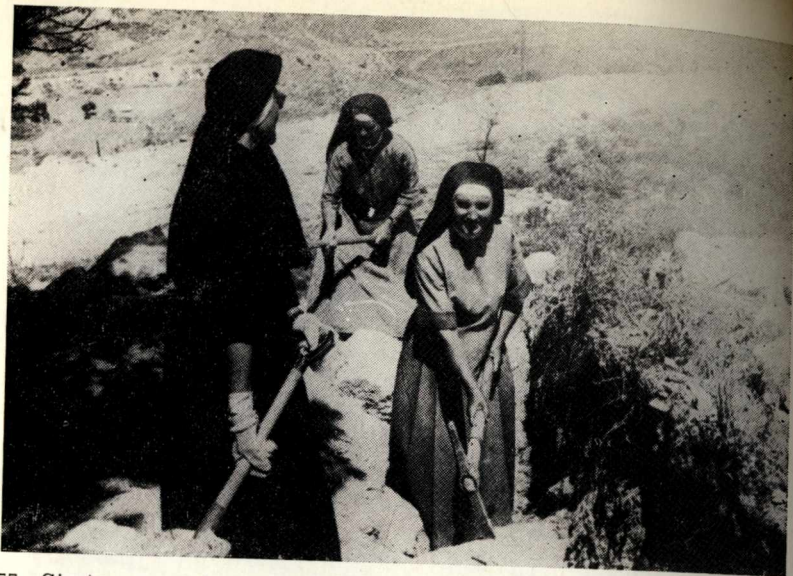
77. Siostry przy kopaniu fundamentu pod Dom Pokoju — Sierociniec na Górze Oliwnej.
