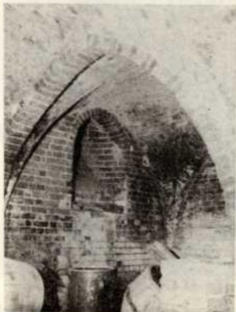
4. Sandomierz, klasztor dominikanów, fragment piwnicy pod refektarzem
