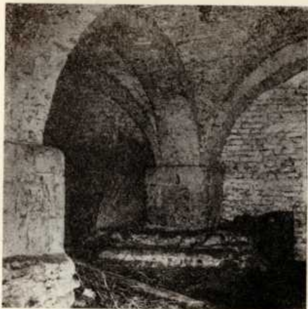
3. Kraków, klasztor dominikanów, fragment piwnicy pod refektarzem
